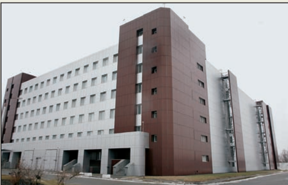
Приміщення Центрального сховища після капітального ремонту.
