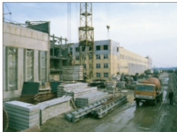
Будівництво Банкотної фабрики.
