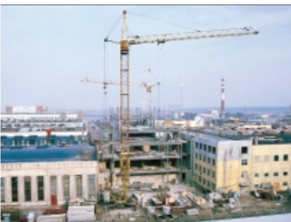
В окремі дні на спорудженні Банкнотної фабрики працювало до тисячі чоловік. Усього через два роки після початку будівництва на підприємстві було виготовлено першу партію гривень.
