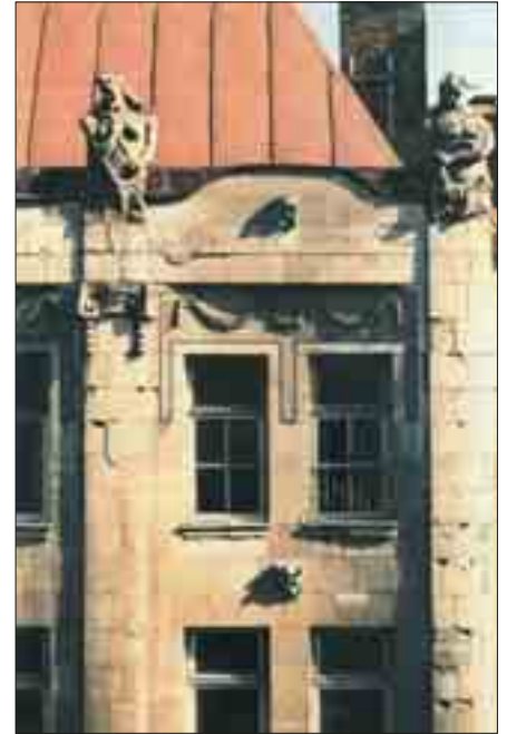
Фрагмент фасаду будинку колишнього Трієстського страхового товариства (вул. Коперника, 3).
