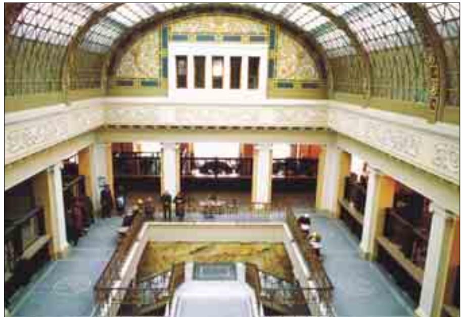
Головний операційний зал управління НБУ у Львівській області виконано із застосуванням новаторських конструкцій — скляних склепінь і скляної підлоги.
